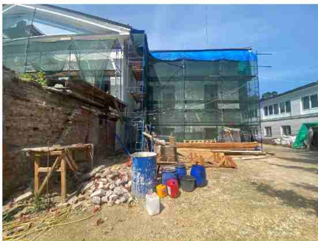
Илл. 24. Дворовой фасад. Внутренняя территория объекта, подлежащая благоустройству.
