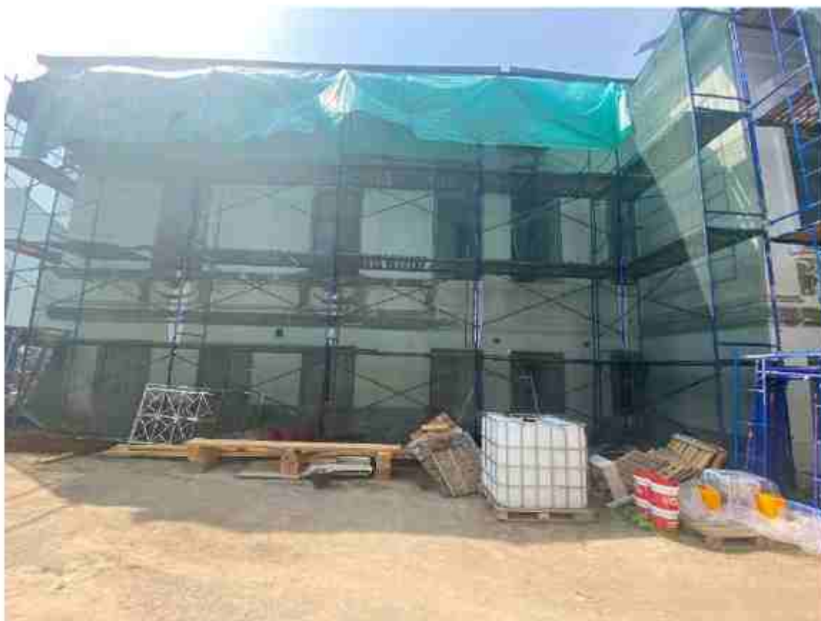
Илл. 21. Дворовой фасад, внутренняя территория объекта, подлежащая благоустройству
