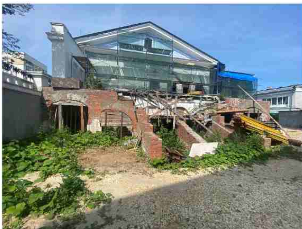
Илл. 26. Дворовой фасад. Внутренняя территория объекта, подлежащая благоустройству.
