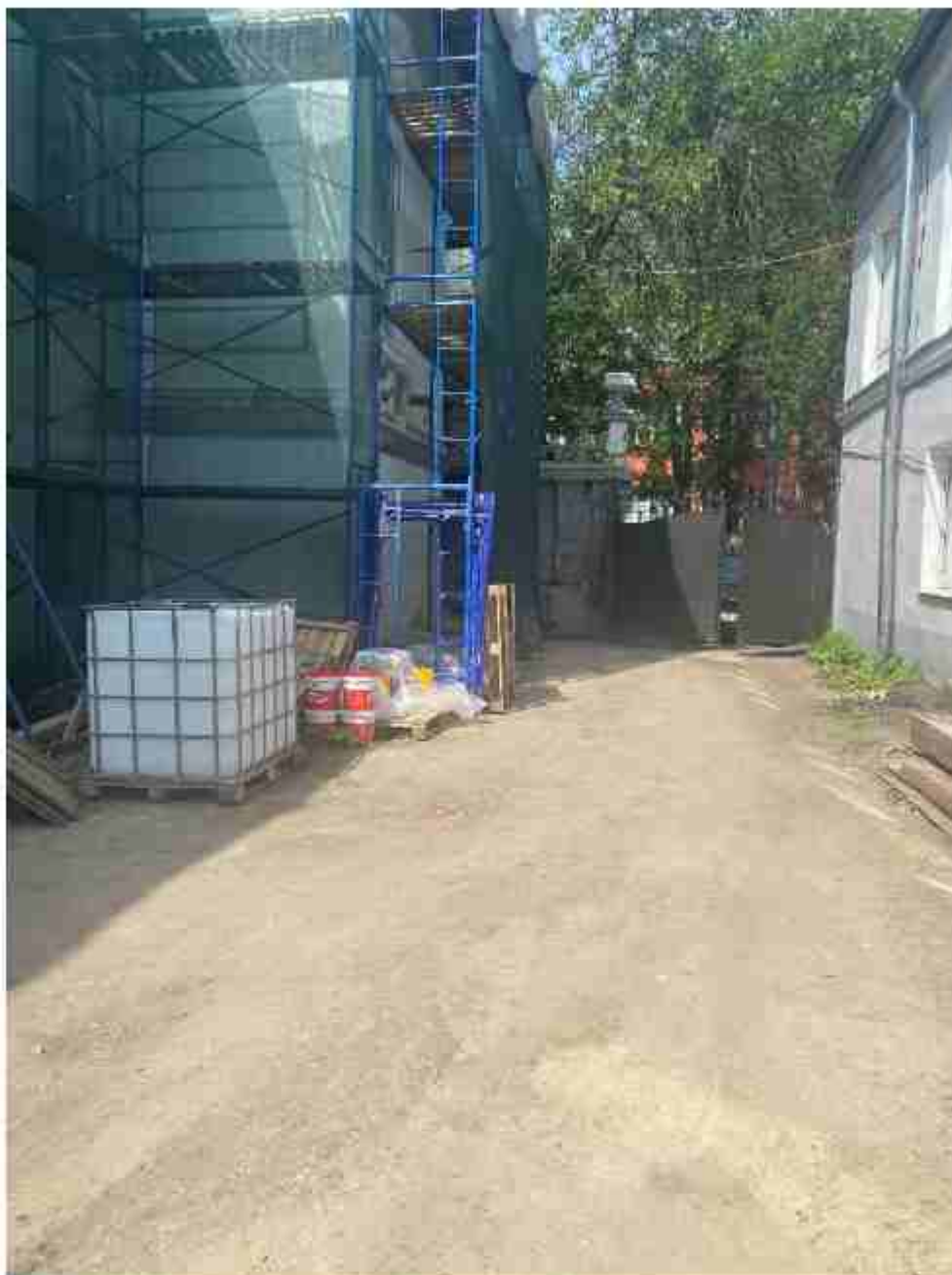
Илл. 22. Внутренняя территория объекта, подлежащая благоустройству. Вид на ворота.
